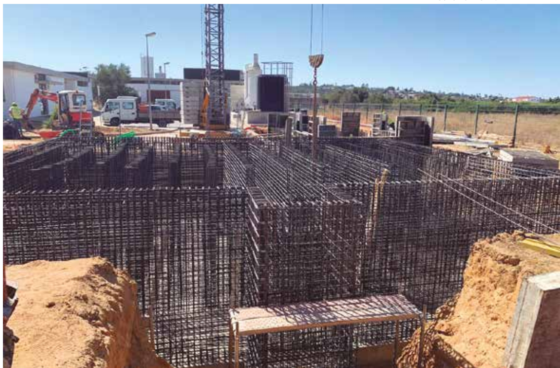
As obras na ETAR da Boavista prosseguem a bom ritmo e devem estar concluídas até final do ano
