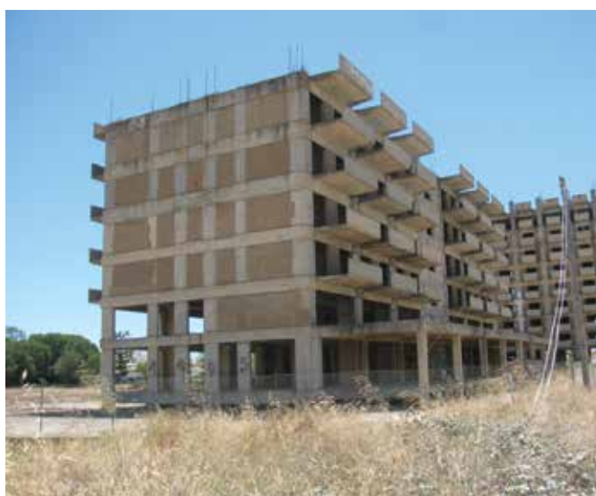
Torres da Torralinha vão ser demolidas
