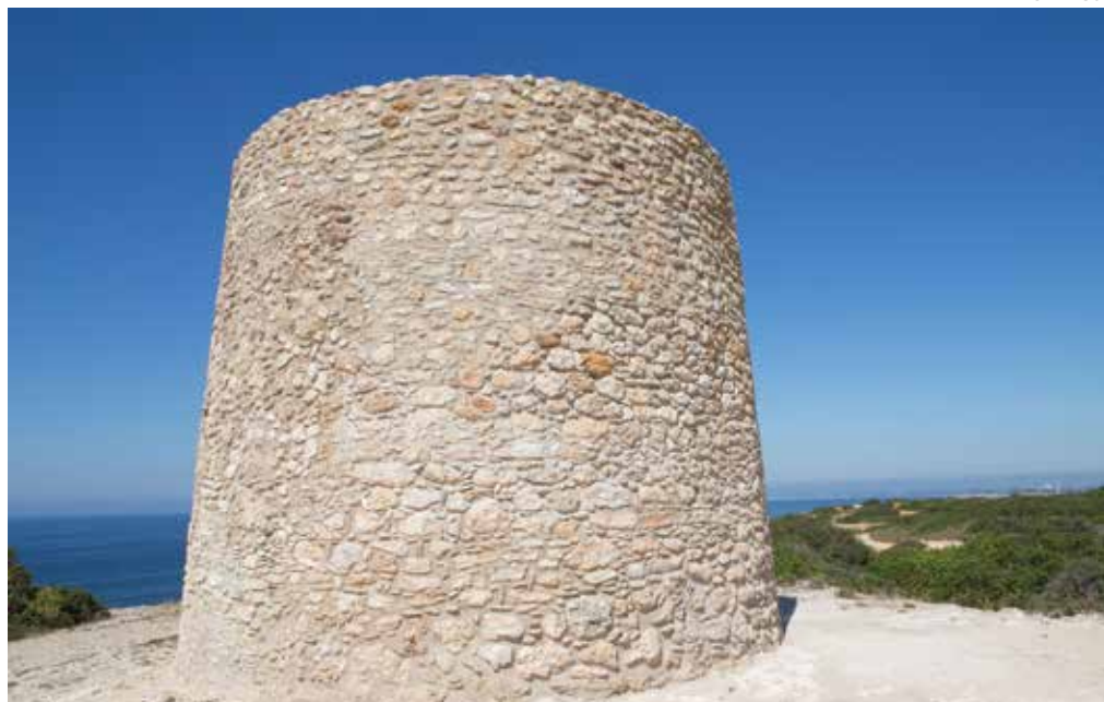
A recuperação da Torre da Lapa ficou concluída em 2017, ano em que avançou o processo de classificação
