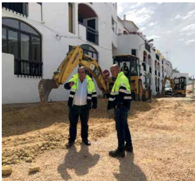
Obras no centro da cidade decorrem em tempo de pandemia
