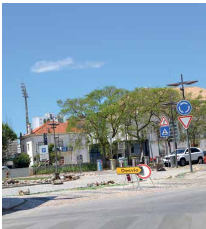
Ruas junto ao Largo Heliodoro Salgado também sofrem obras
